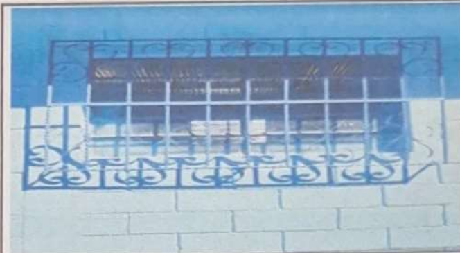
Foto 2: Fabricación e instalación de balcones de hierro en ventana en el módulo 2
