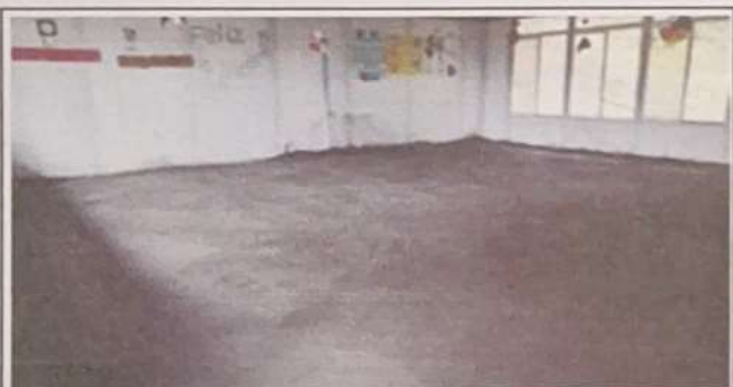
Foto 3: Sustitución de piso de torta de concreto por piso de fibra de cemento en el módulo 2
