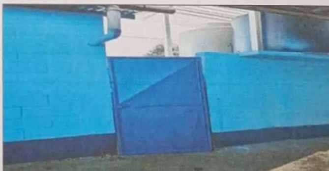
Foto 6: Sustitución de puerta de metal en el módulo 2
